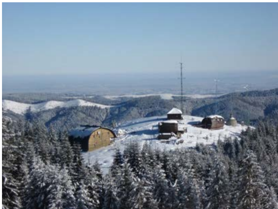
Рисунок 1. Готель «Ковчег» Будівля готелю «Ковчег» споруджена з натуральної деревини у вигляді перевернутого човна, – конструктивно орієнтована на енергозбереження. Все дерево ззовні та усередині покрито натуральним бджолиним воском, що зберігає природний вигляд деревині і є більш екологічним в порівнянні з алкідними лаками.
